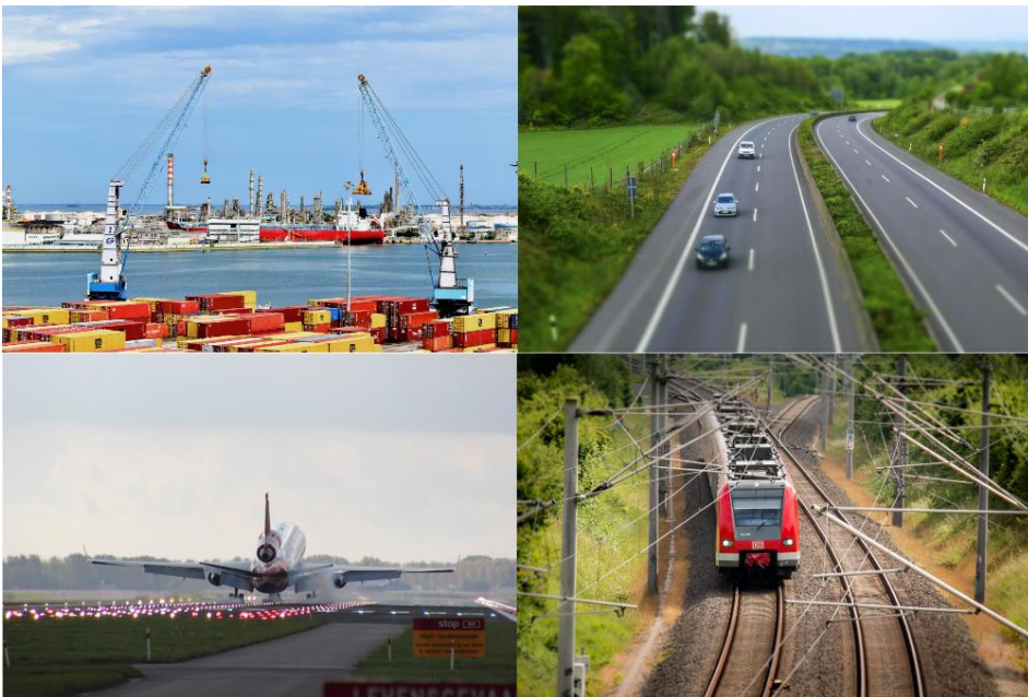
Slika 1-2. Primjeri transportne infrastrukture
